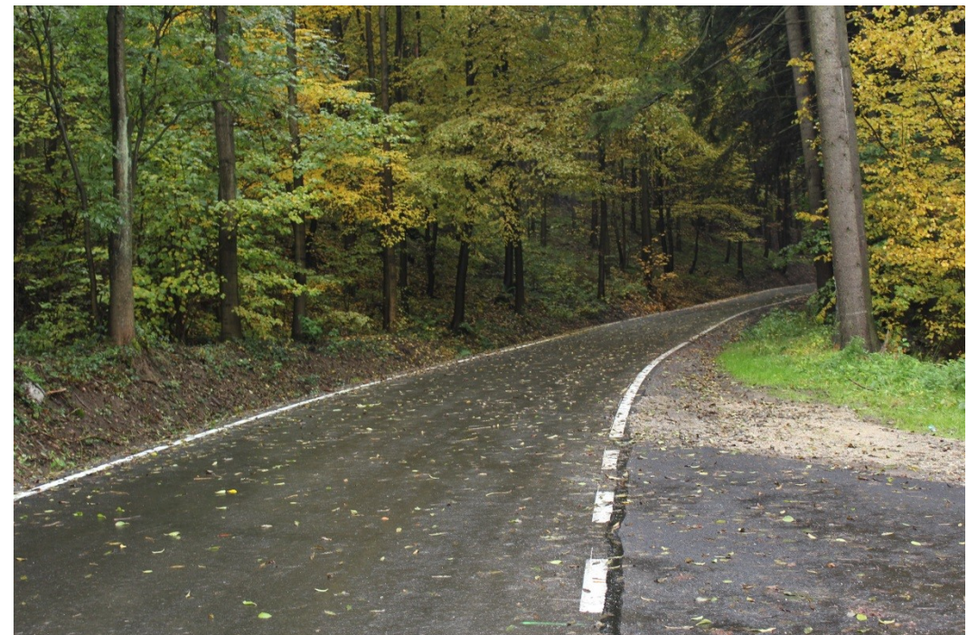
Droga po przebudowie.
