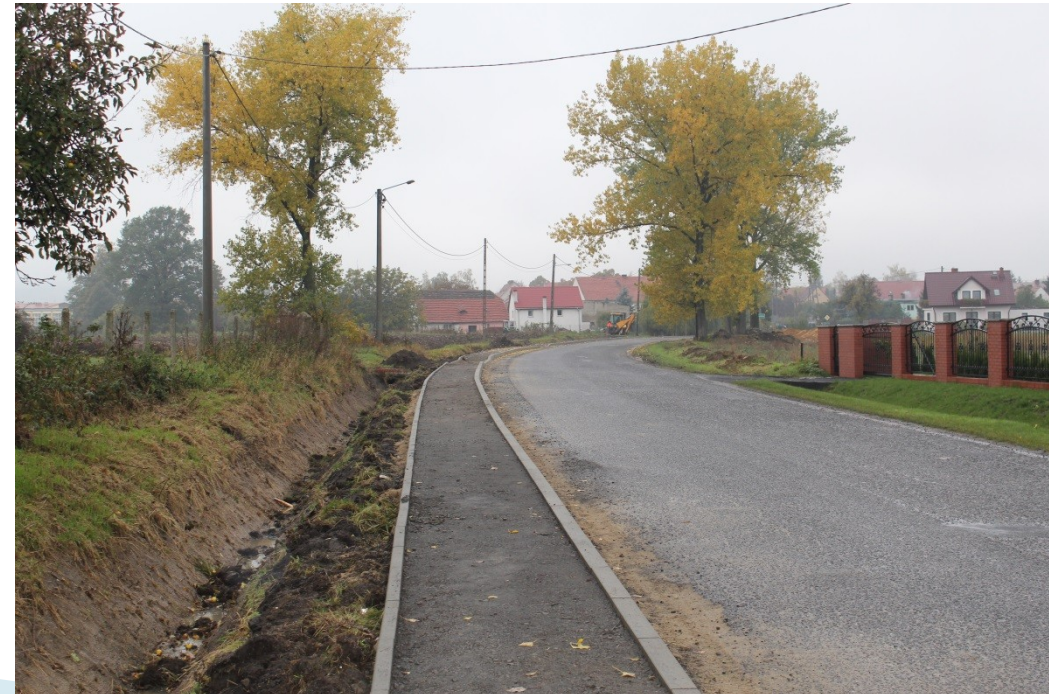
Chodnik w trakcie realizacji.
