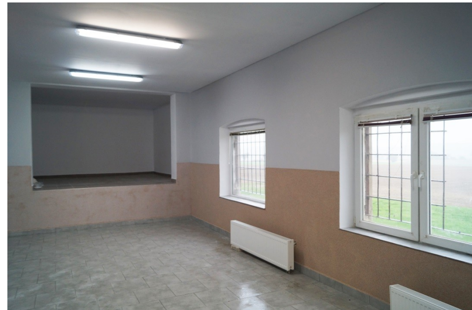
Sala po remoncie
