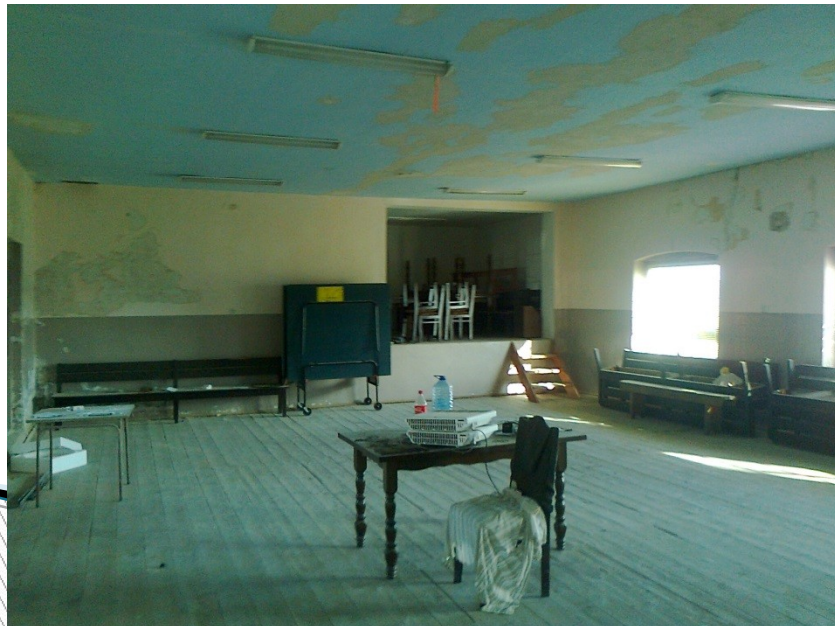
Sala przed remontem
