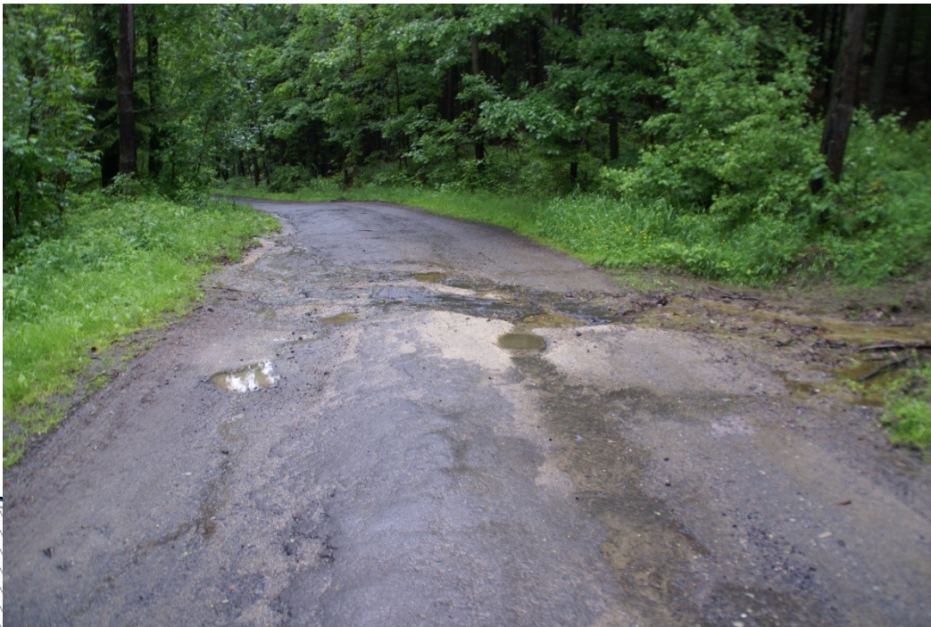
Droga przed przebudową.
