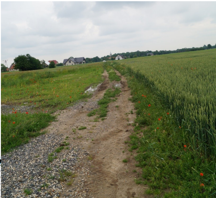
Droga przed realizacją inwestycji.
