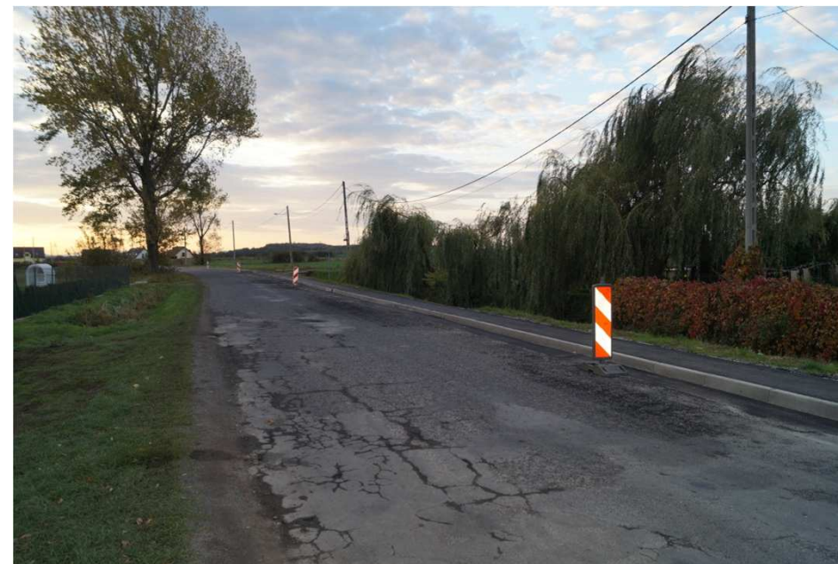
Chodnik w trakcie realizacji.
