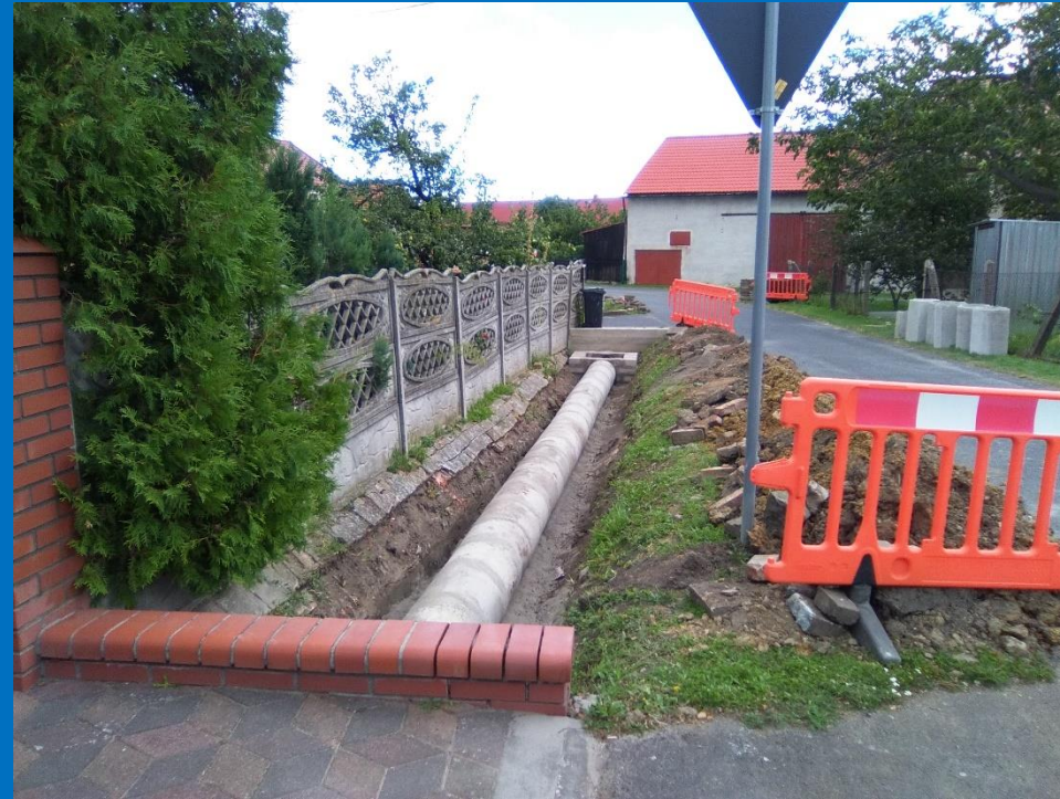
Inwestycja w trakcie realizacji
